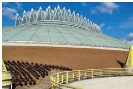
Böschung nach Verlegung des Kokosnetzes
