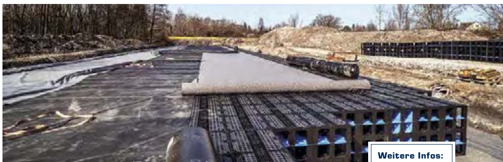
Kernelement der Entwässerungsplanung ist der Bau eines unterirdischen Rückhaltebeckens mit einem Speichervolumen von rund 1.850 m 3
