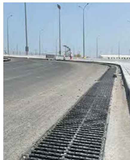
Entwässerung der Straßen mit MEADRAIN EN und passenden Gussabdeckungen
