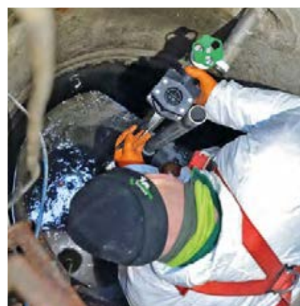
Einbau des vormontierten Einbausets DN 40
