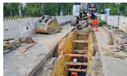
Ein Rohr DN 400H wird in den Rohrgraben abgelassen
