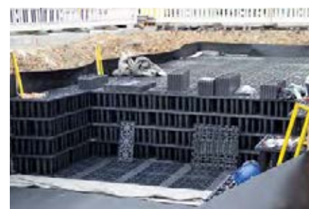
Der dreilagige Aufbau verhindert den unkontrollierten Wasseraustritt aus den Modulen
