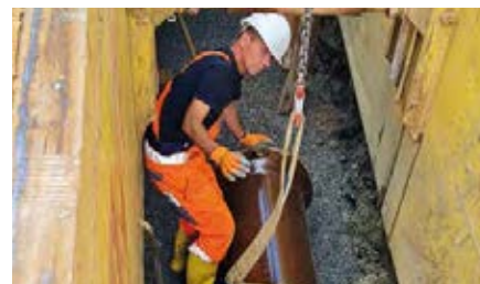
Das Rohr wird ausgerichtet und eingeschoben
