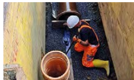
Der Rohreinschub erfolgt mit einer Winde
