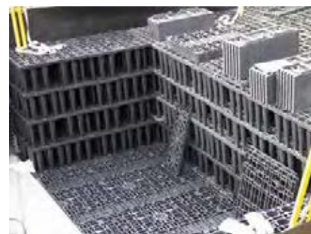
Die Module wurden bei der Montage zu einem Blockverbund zusammengefügt
