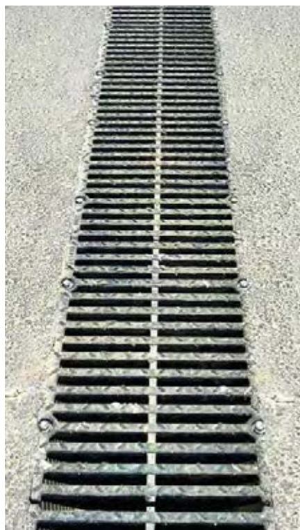
Verschraubte Rinnenabdeckungen bieten Sicherheit beim Überfahren der Entwässerungsstränge
