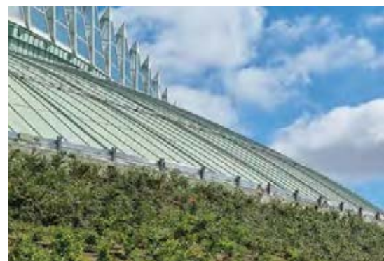
Bepflanzte Böschung inklusive Bewässerungsanlage
