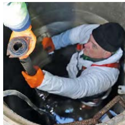
Ausbau der alten korrodierten Schachteinbauten
